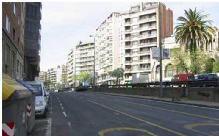
Situació inicial de la calçada costat mar de la Ronda General Mitre (direcció Balmes) a l'alçada del c/Saragossa
