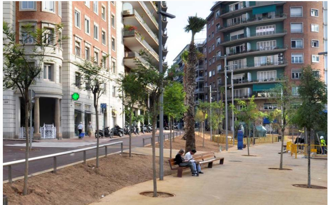
Urbanització en servei (07/10/10)
